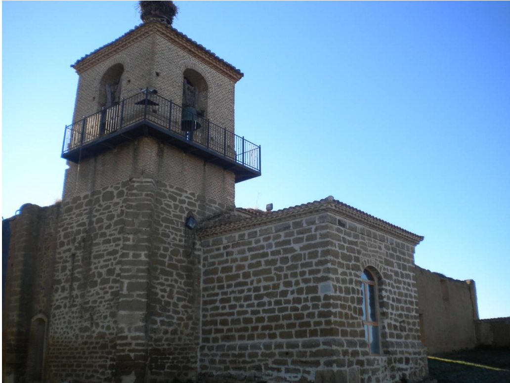
Torre campanario levantada en ladrillo sobre los restos de piedra de la fortaleza-palacio
