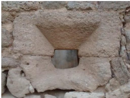
Detalle del hueco abocinado a modo de saetera en el muro de piedra de la iglesia, y restos del pórtico sustentado por columnas de madera sobre basas de piedra, cerrado con ladrillo y adobe
