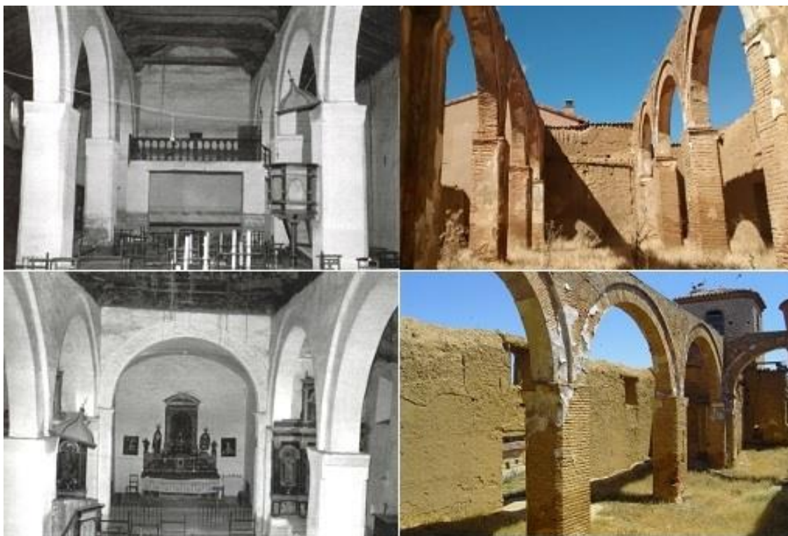
Fotografías del interior de la iglesia de Santiago poco antes de su desaparición (cortesía de la Delegación de Patrimonio de la Archidiócesis de Valladolid) y estado actual
