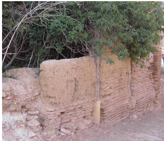
Detalle del hueco abocinado a modo de saetera en el muro de piedra de la iglesia, y restos del pórtico sustentado por columnas de madera sobre basas de piedra, cerrado con ladrillo y adobe
