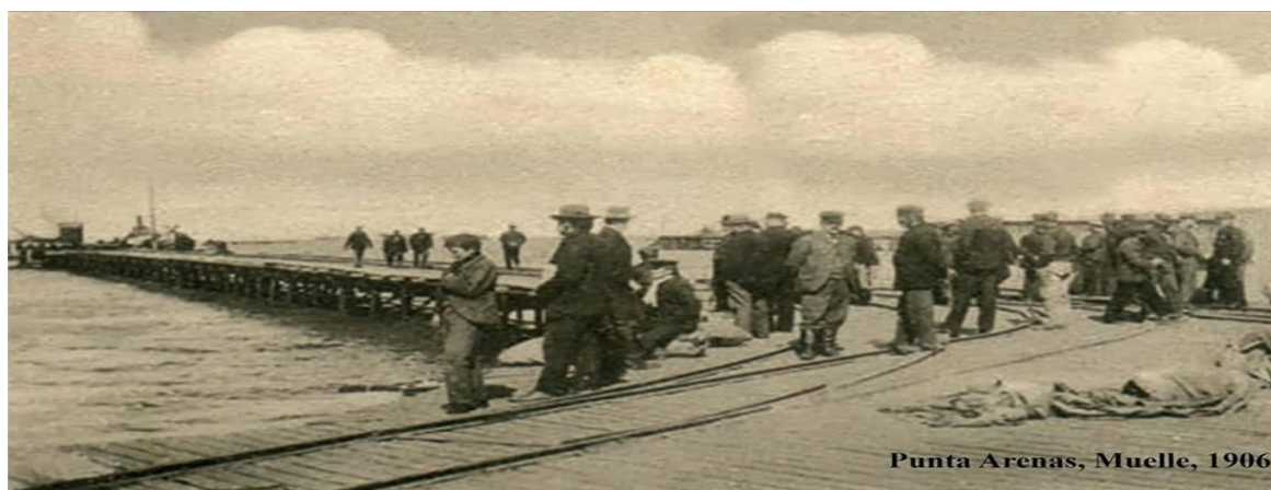
(Muelle Loreto en 1906. Fuente: Enterreno.com)
